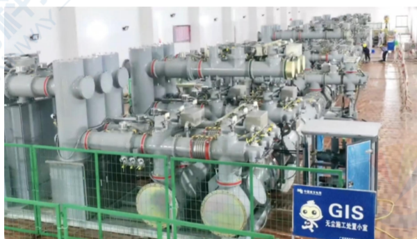
GIS（气体绝缘开关设备）
