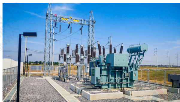
SF 6 绝缘变压器
