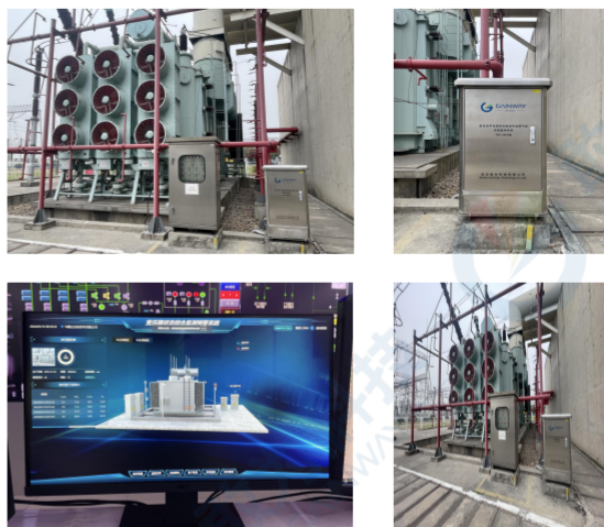
中广核核电变压器在线监测 【核电项目】
